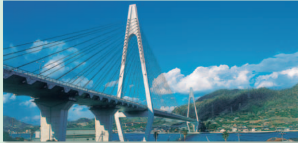
生口橋 写真提供 広島県
